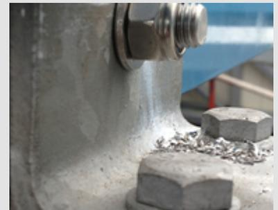
Abb. 5: Bohrspäne oder Reste von Schweißelektroden können "Fremdrost" verursachen, wenn sie nicht entfernt werden.
