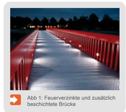
Abb 1: Feuerverzinkte und zusätzlich beschichtete Brücke
