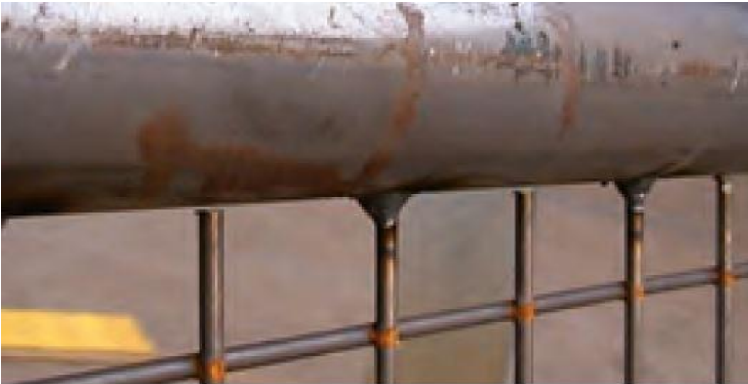
Primer ograje z varjenim polnilom; velikost polja ni prevelika.
