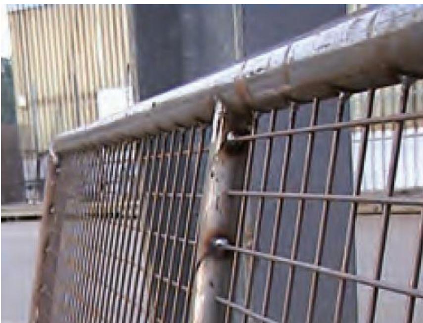
Predvidite možnost raztezanja: križno privarite samo vsako drugo palico in upoštevajte razmak palic do okvirja pribl. 2 mm.
